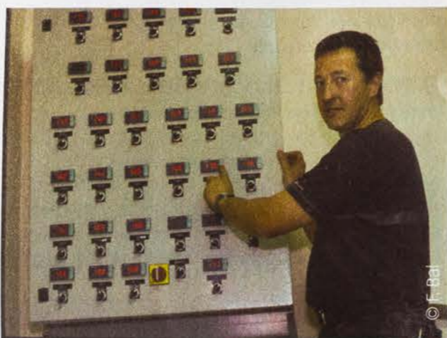
« Pierre-Yves et Olivier Fichet (sur la photo) se sont équipés d'un tableau électronique de commande des cuves thermorégulées. »
